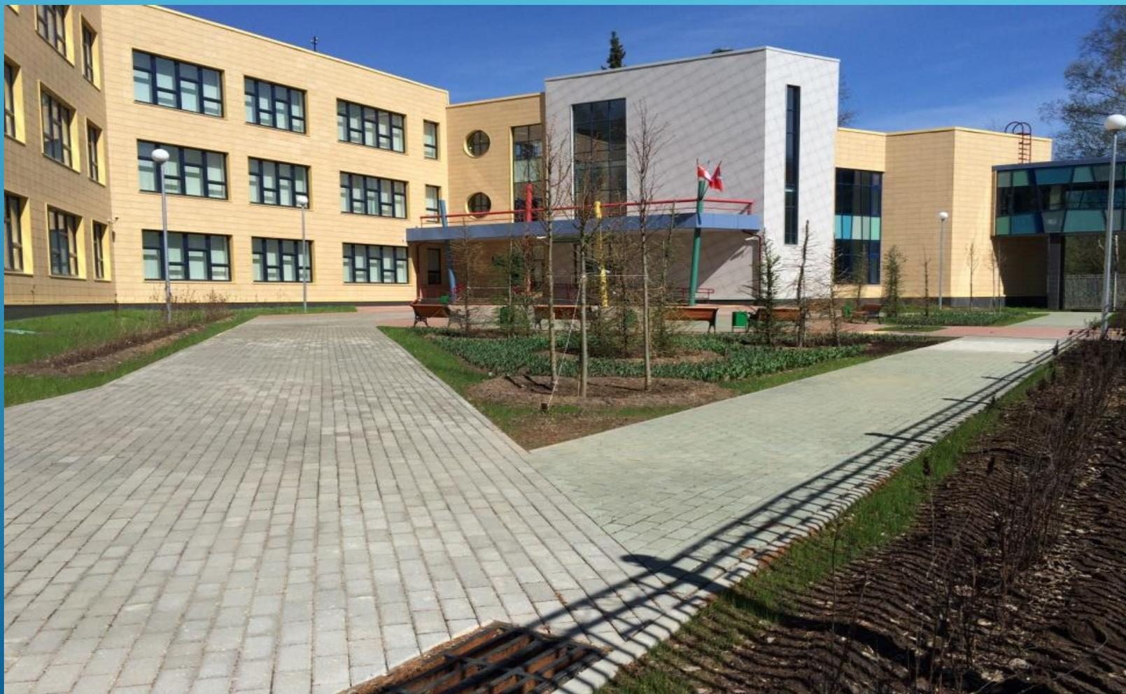
При проектировании здания использована каркасная система – монолитные колонны и диски перекрытия. Поэтому блок начальных классов получился одним из самых «дешевых» в Москве с точки зрения строительства
