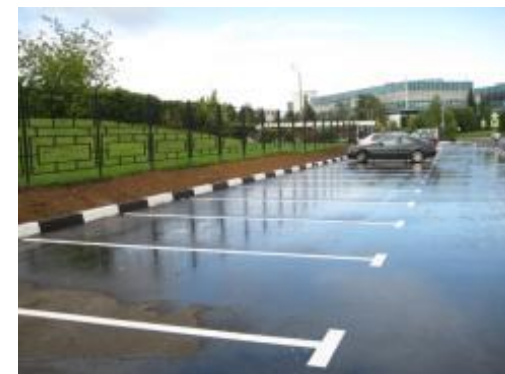
ПАРКОВКИ, 2-Й ЗАПАДНЫЙ ПРОЕЗД
