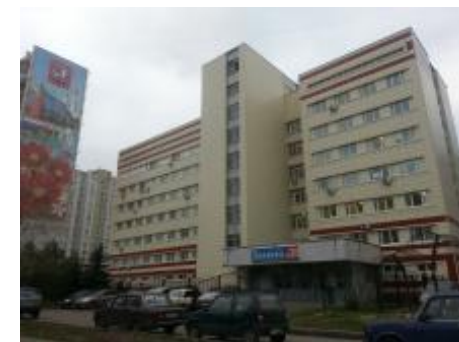
РЕМОНТ ФАСАДА ГП № 230
