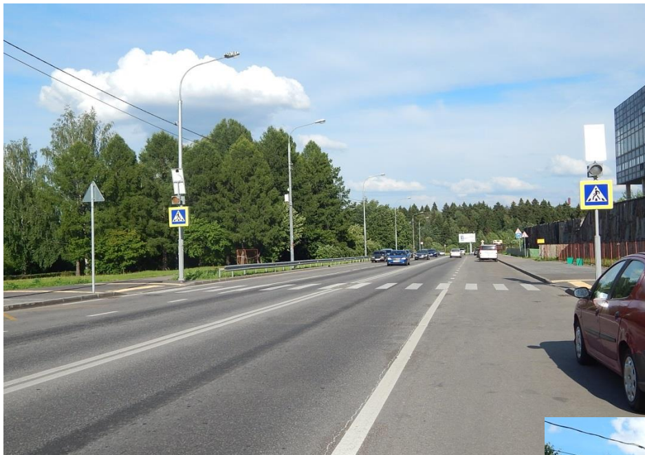
Реконструкция Озёрной аллеи (1 п.к.)
