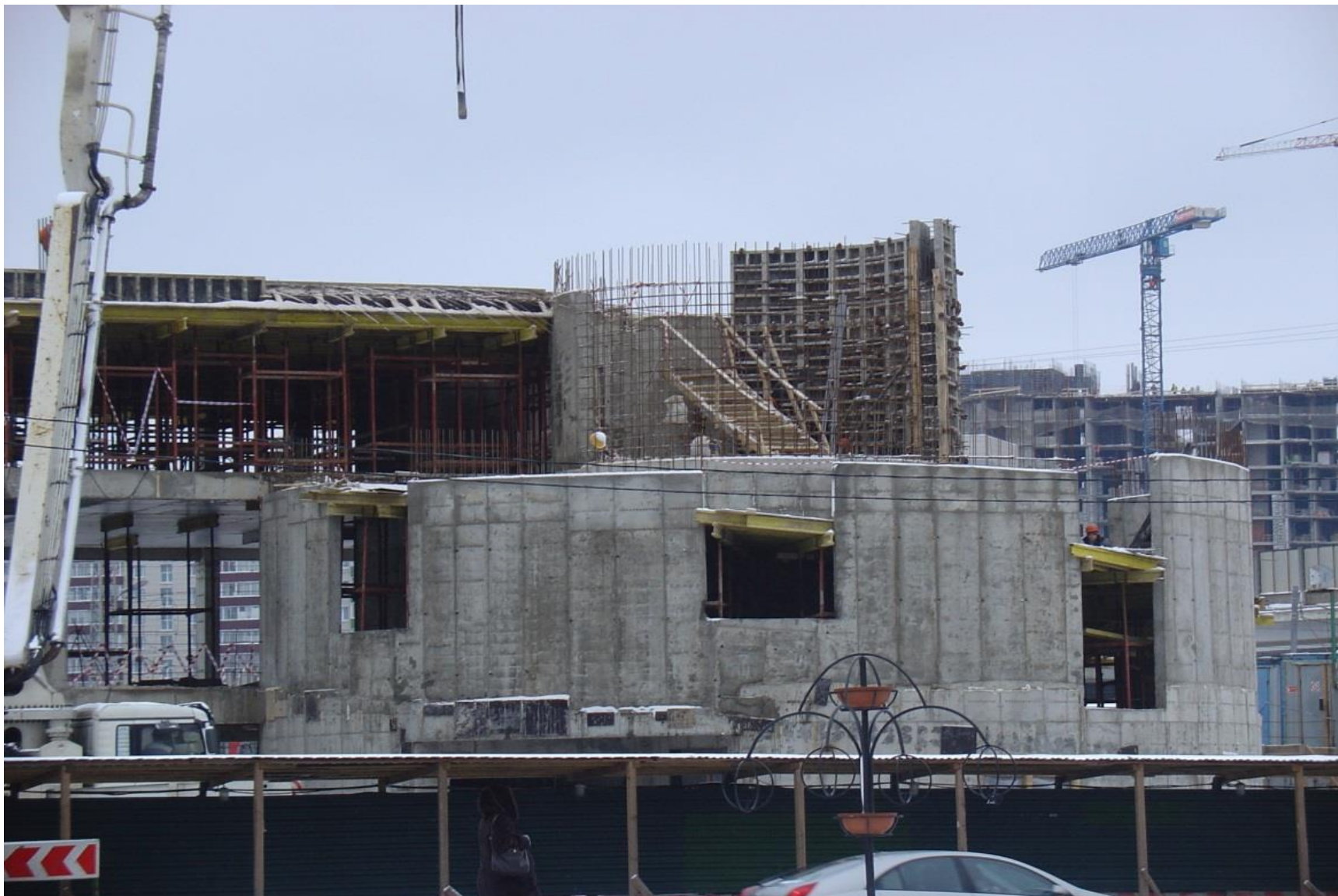
Четырехэтажный гараж-стоянка с одним подземным этажом на ул.Новокрюковская
