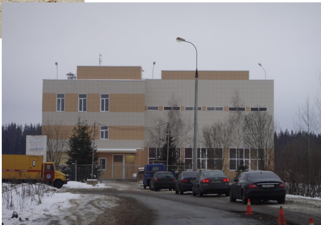
Реконструкция Ново-Крюковской КНС
